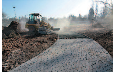
Errichtung der Zuwegung und Baumpflanzungen
