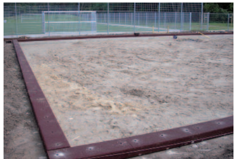
Das Beach-Volleyballfeld in der Bauphase
