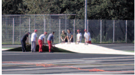
Verlegen des neuen ‚Teppichs‘
