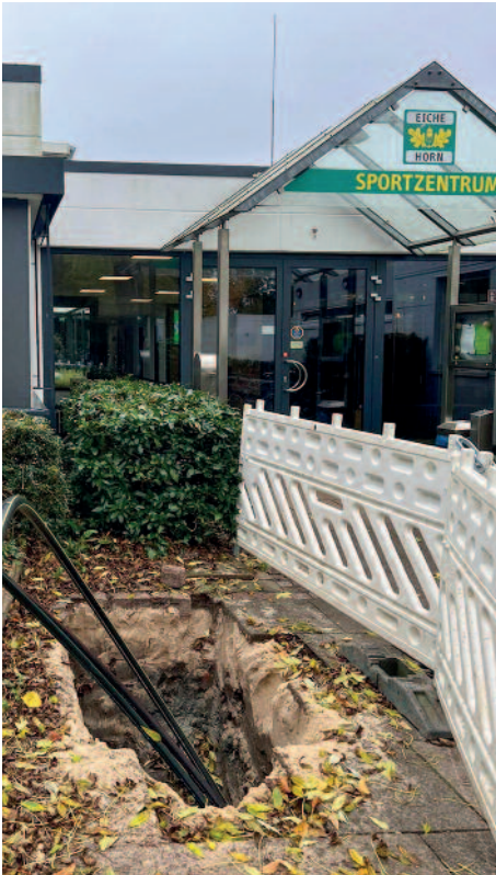
Die Glasfaser-Leitung wird verlegt (Foto: Angelo Caragiuli)
