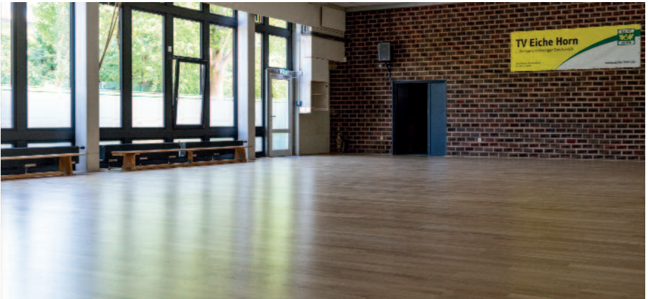
Das schöne neue Parkett in der Mehrzweckhalle
