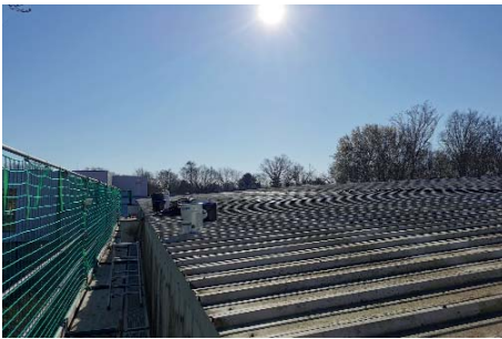
Auch das Dach musste repariert werden
