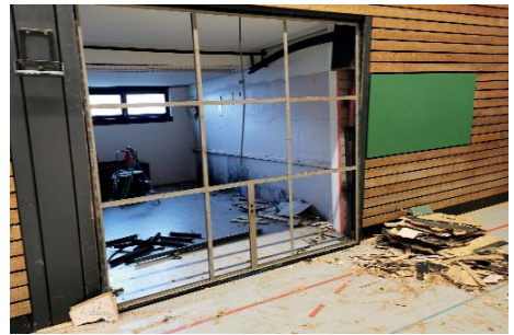
Umbau des Geräteraumtores
