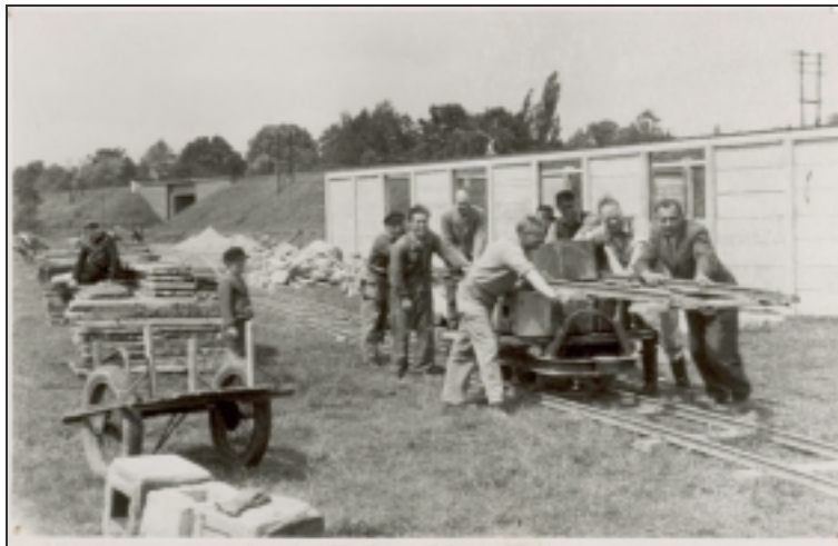
Aufbau der Lüning-Baracke (1950)
